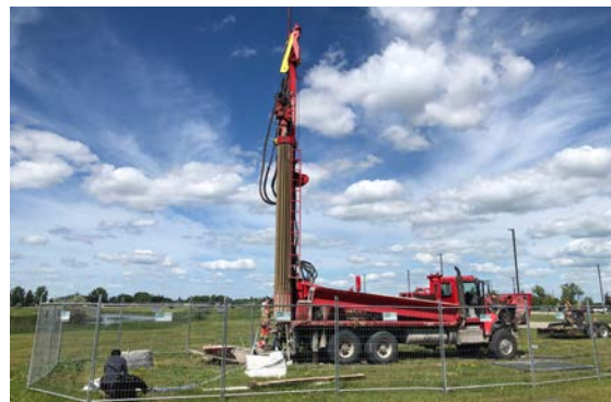
Installation d'un puits géothermique à la Monnaie de Winnipeg
